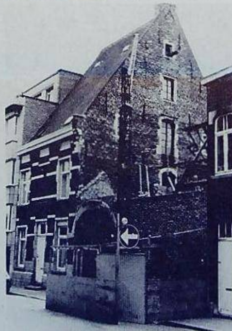
"Bewaard gebleven gedeelte van een groot en waardig langshuis in traditionele bak- en zandsteenstijl van XVII. Zadeldak met steile helling. Voorgevel aangepast gedurende XIX en XX." Dit staat te lezen in de inventaris van het kultuurbezit in Vlaanderen van het Ministerie van Nederlandse Cultuur Bouwen door de eeuwen heen, en slaat op het nummer 71 in dezelfde Tervuursestraat. Intussen zijn er daar echter bouwwerken aan de gang. Buiten weten van de bewoner van het nummer 71 om heeft de stad de aanpalende, waardevolle poort en gang verkocht. Een nieuwe poort is reeds gebouwd. Weldra mag bovengaande passage uit ons cultureel patrimonium worden geschrapt.
